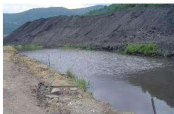
شکل ۲: نمایی از سد باطله و استخر آبگیری باطله کارخانه زغالشویی زیرآب
